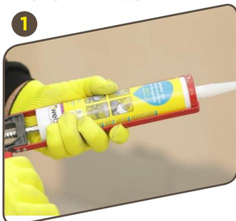
1. Cortar el extremo del obturador del cartucho y roscar el pico aplicador. Introducir el conjunto en la pistola aplicadora.
