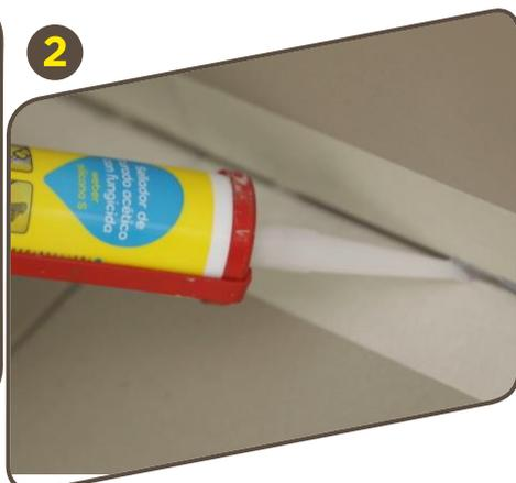
2. Cortar la punta del pico a bisel en la sección deseada. Aplicar de forma lineal.
